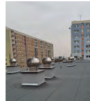
Remont dachu – Turbowenty, Ogrody 26, Z. Natkowskiej 7
