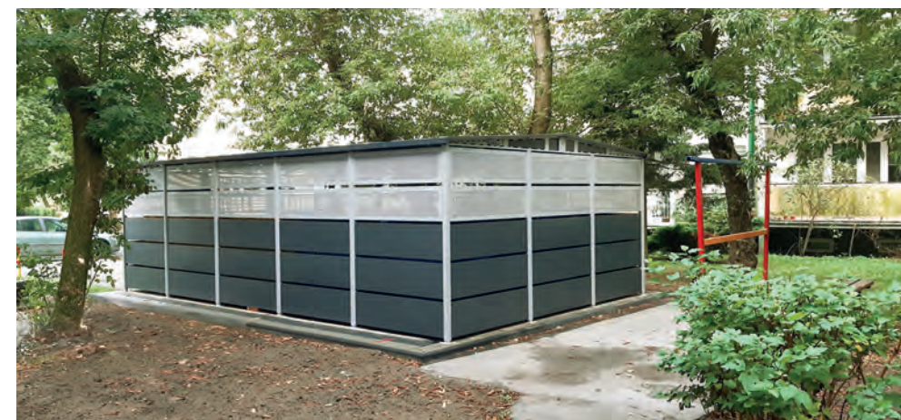
Nowa wiata śmietnikowa
