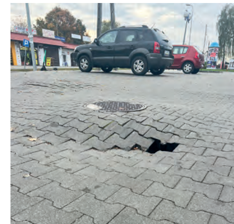
Glinki 32, zapadnięcie instalacji
