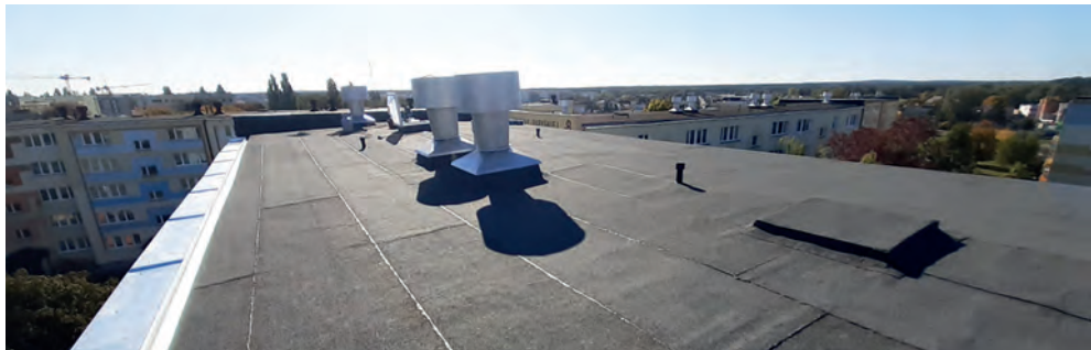
Remont pokrycia dachowego
