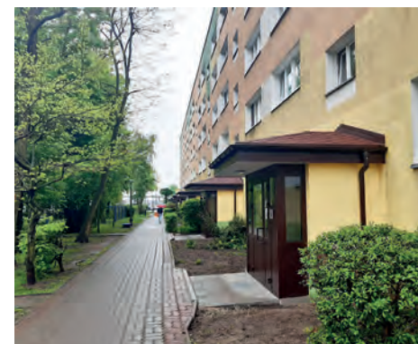
Dobudowanie portali wejściowych przy ul. Węgierskiej
