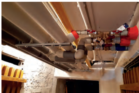
Wymiana instalacji zw. I cwu. T. Boya-Żeleńskiego
