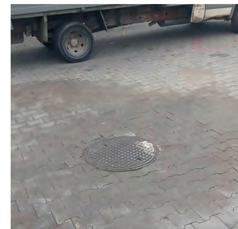
Glinki 32, zapadnięcie instalacji
