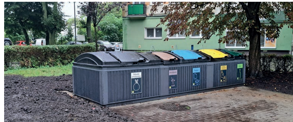
Kontenery półpodziemne przy nieruchomości Moczyńskiego 1 (obsługujące 3 wieżowce przeznaczone dla 220 osób)
